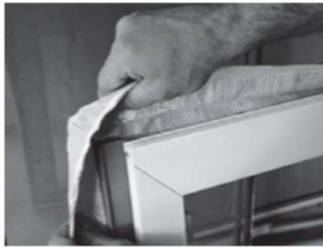
Рис. 7.6.4.4. Крепление пароизоляционной ленты к торцу коробки.
